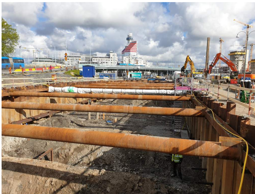
Schakt för Hisingsbrons broramp vid Nils Ericsonterminalen. Foto Johannes Tornborg
